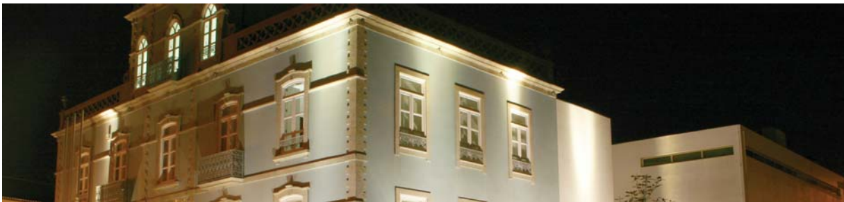
Designação ▶ Casa da Cultura de S. João da Madeira Ano de Conclusão ▶ 2005 Cliente ▶ Constructora San José
