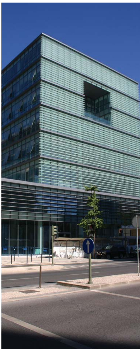
Designação ▶ Edifício escritórios da Expo Ano de Conclusão ▶ 2006 Cliente ▶ Constructora San José
