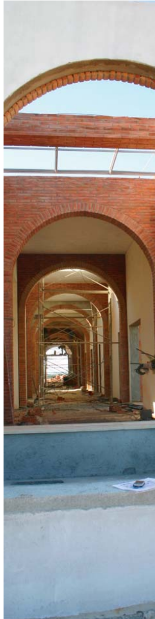
Designação ▶ Emp. do Redondo - Évora Ano de Conclusão ▶ em execução Cliente ▶ SA Machado & filhos
