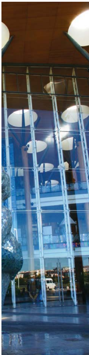
Designação ▶ Almada Forum Rede geral de terras e estaleiro Ano de Conclusão ▶ 2001 Cliente ▶ Constructora San José
